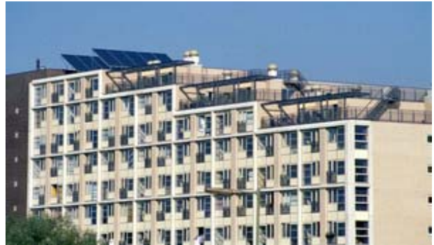
f) Impianto solare impiegato per il riscaldamento di grandi edifici residenziali – ESTIF
