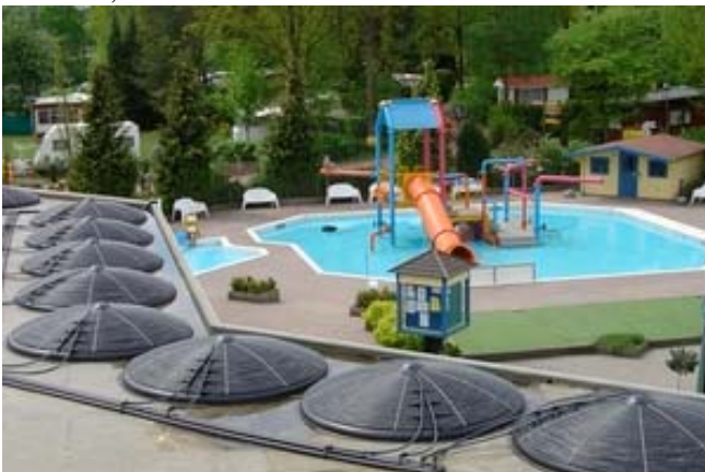
c) L'impianto solare per il riscaldamento di una piscina – ESTIF
